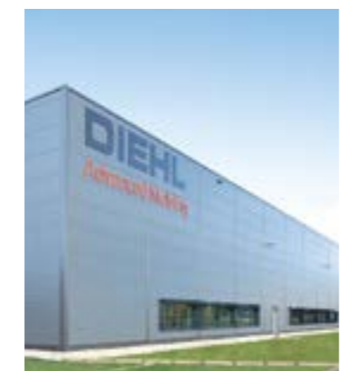
Die Produktionshalle in Zehdenick: Hier werden die Zellkontaktiersysteme hergestellt. Foto: DAM
