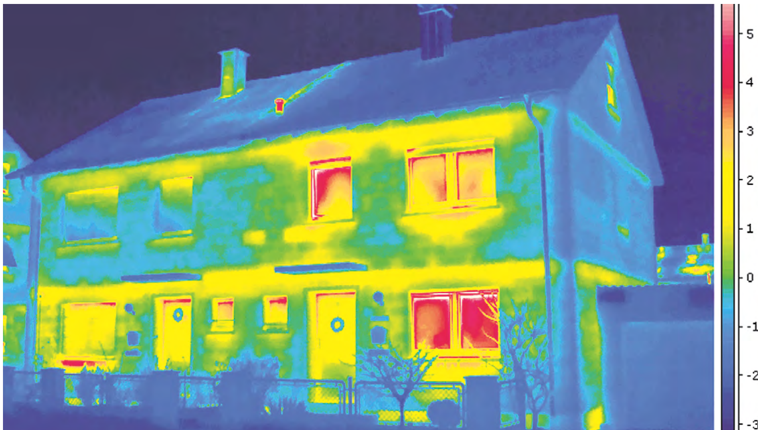
Kein Gestaltungsvorschlag für den Fassadenmaler, sondern Analysedokument für die Effizienz der Gebäudehülle – das Thermofoto.
